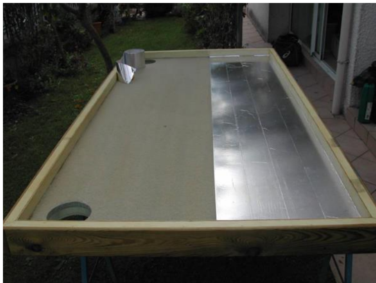
Chicanes pour la circulation de l'air et qui supportent les ardoises
